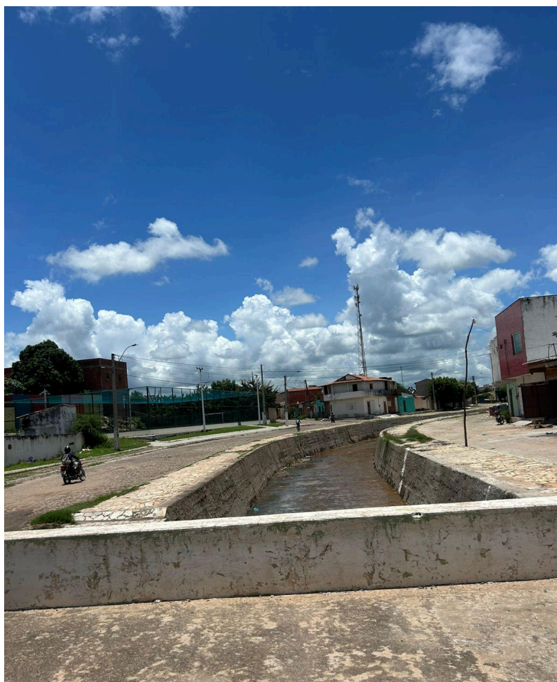
IMAGEM 11. Trecho de riacho canalizado, Rua Carlos Martins de Moraes, Sede Urbana de Brejo Santo-CE
