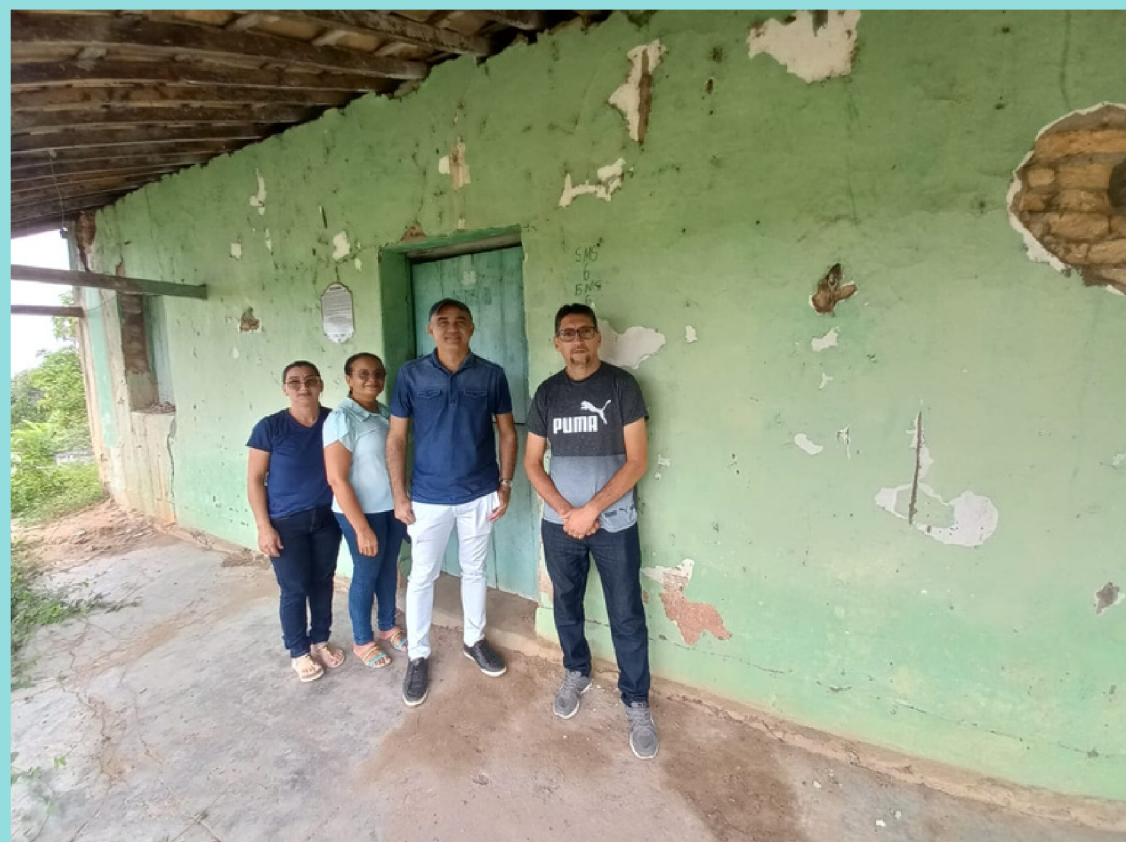
CASARÃO ANTÔNIO GRANGEIRO - SALVA TERRA
